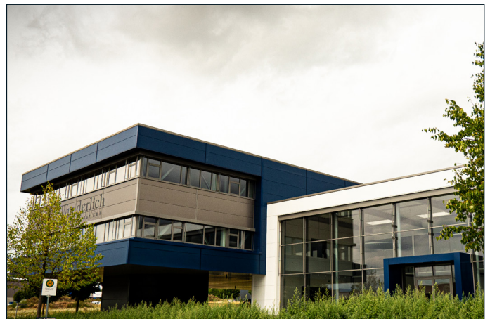
Der freitragende Verwaltungstrakt mit dem großzügigen Ausstellungsraum
